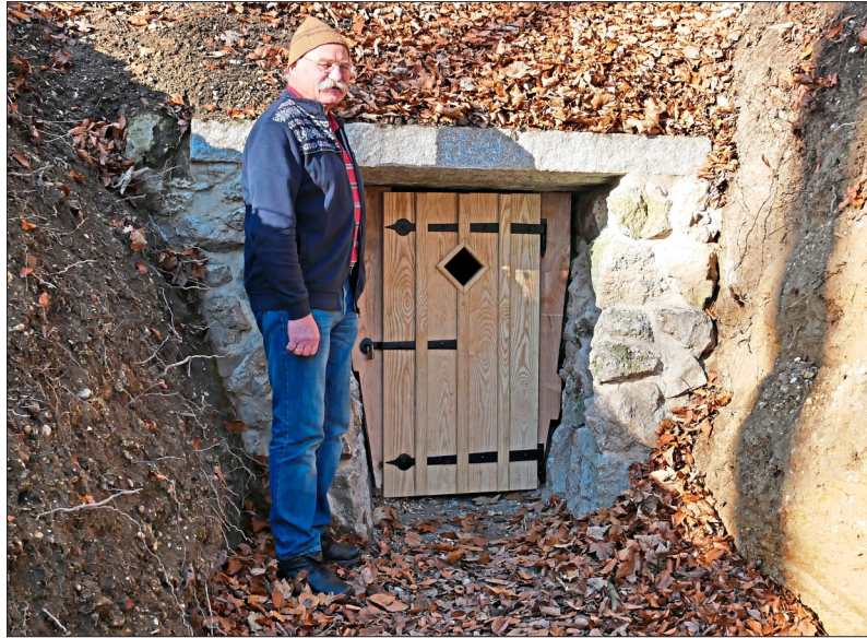
Der „Mann für alle Fälle“: Helmut Rogger hat das solide Tor gebaut.
